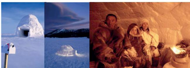
Portanto, a irradiação de uma pessoa ou uma fogueira, por exemplo, não consegue sair, provocando o aquecimento do ar ambiente, criando um clima suportável. Uma pequena abertura no topo da construção permite que o ar saia e se renove, através da convecção.
